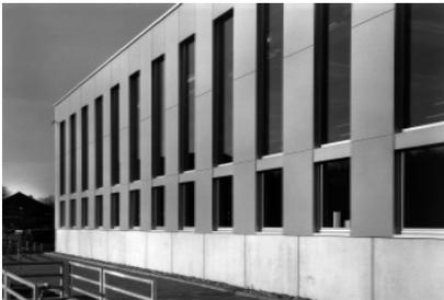
Fassade mit grossformatigen Etemitplatten und Oblichtern
