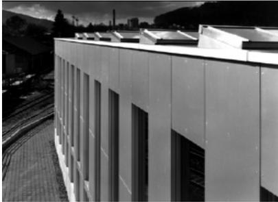
Fassade mit grossformatigen Etemitplatten und Oblichtern
