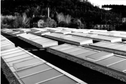
flache Oblichtbänder mit Lüftungsfügel
