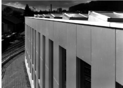
Fassade mit grossformatigen Eternitplatten und Oblichtern
