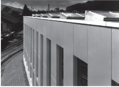
Fassade mit grossformatigen Eternitplatten und Oblichtern
