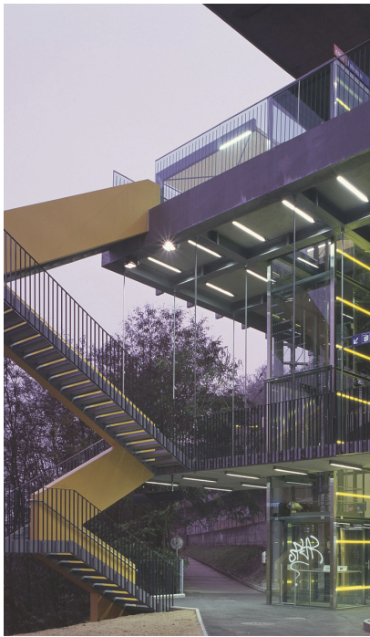
RBS Station Felsenau Nachtaufnahme
