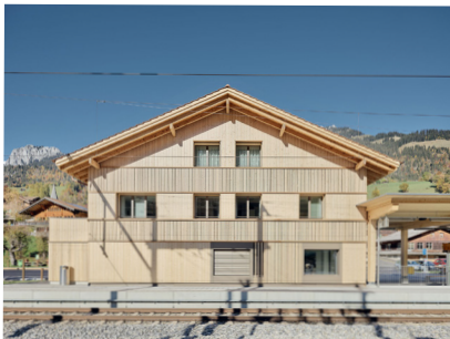
Aufnahmegebäude BLS Bahnhof Erlenbach
