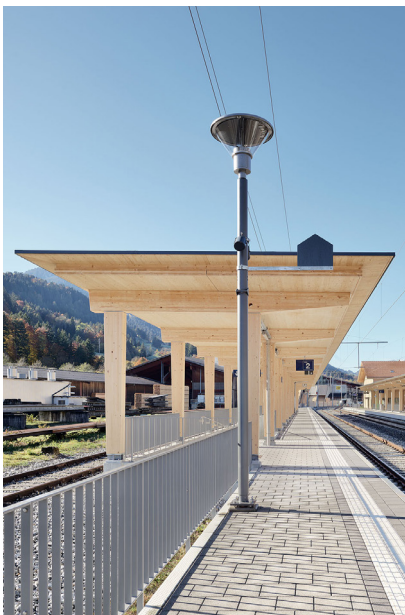
Perrondach BLS Bahnhof Erlenbach
