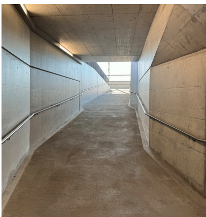
Unterführung SBB Bahnhof Brugg
