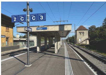
Perrondach SBB Bahnhof Uttigen
