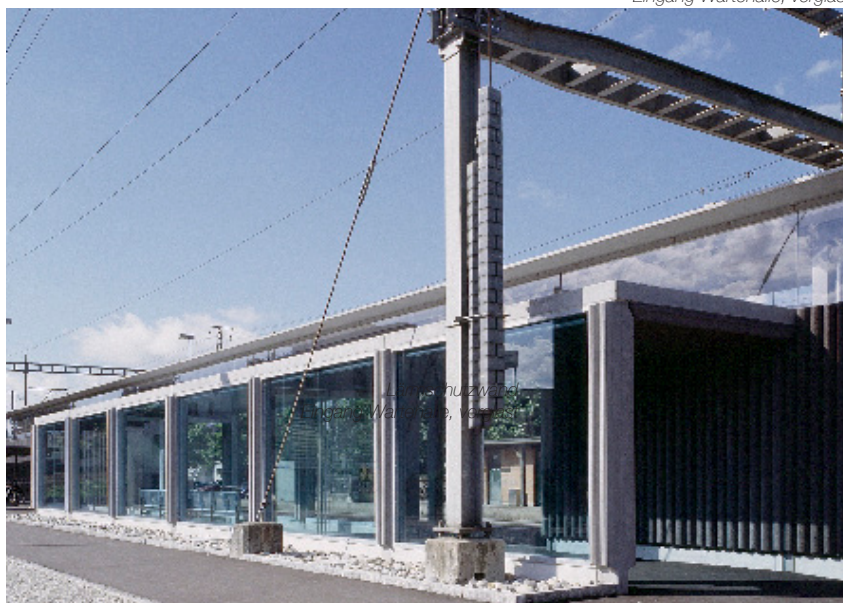
Lärmschutzwand Eingang Wartehalle, verglast
