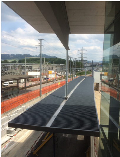
Neues Hauspersondach Ansicht aus Passareille
