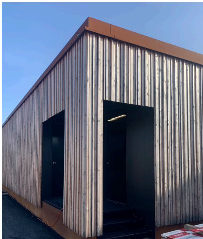
Normtechnikgebäude BLS Kirchberg
