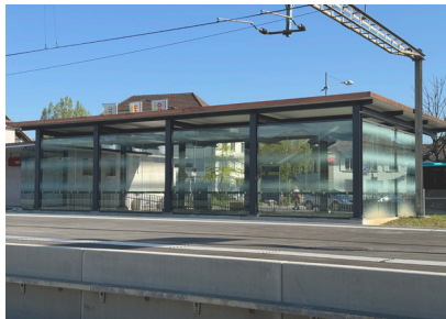
Unterführung SBB Bahnhof Brugg
