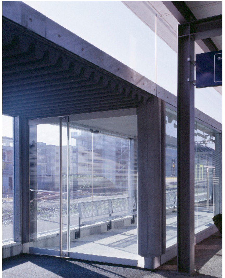
Aussenperrondach und Lärmschutzwand Bahnhof Rubigen
