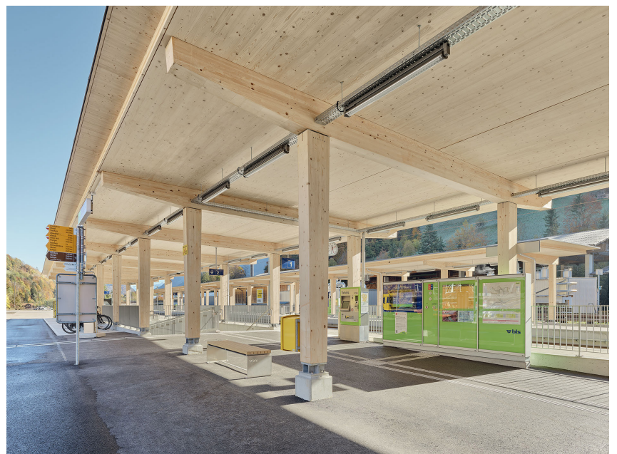
Perrondach BLS Bahnhof Erlenbach
