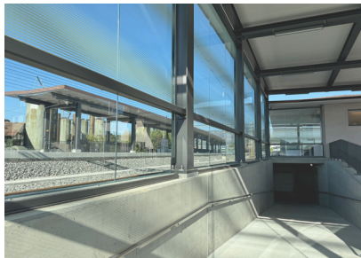
Unterführung SBB Bahnhof Brugg
