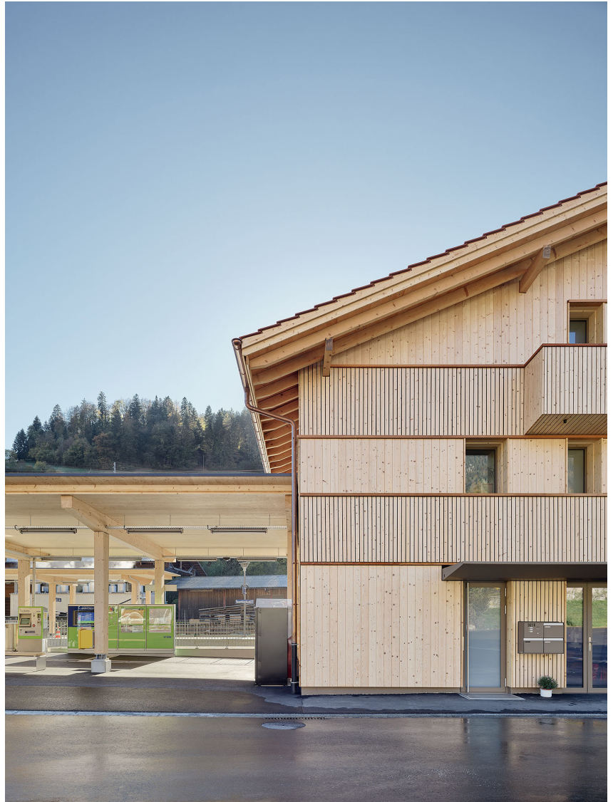
Gesamtansicht BLS Bahnhof Erlenbach
