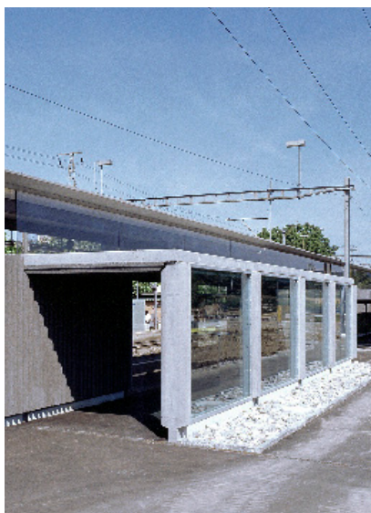
Lärmschutzwand mit Eingang auf Aussenperron SBB
