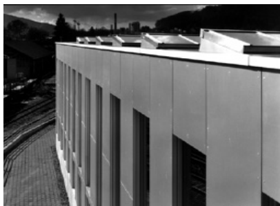
Fassade mit grossformatigen Eternitplatten und Oblichtern
