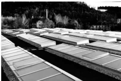
flache Oblichtbänder mit Lüftungsfügel
