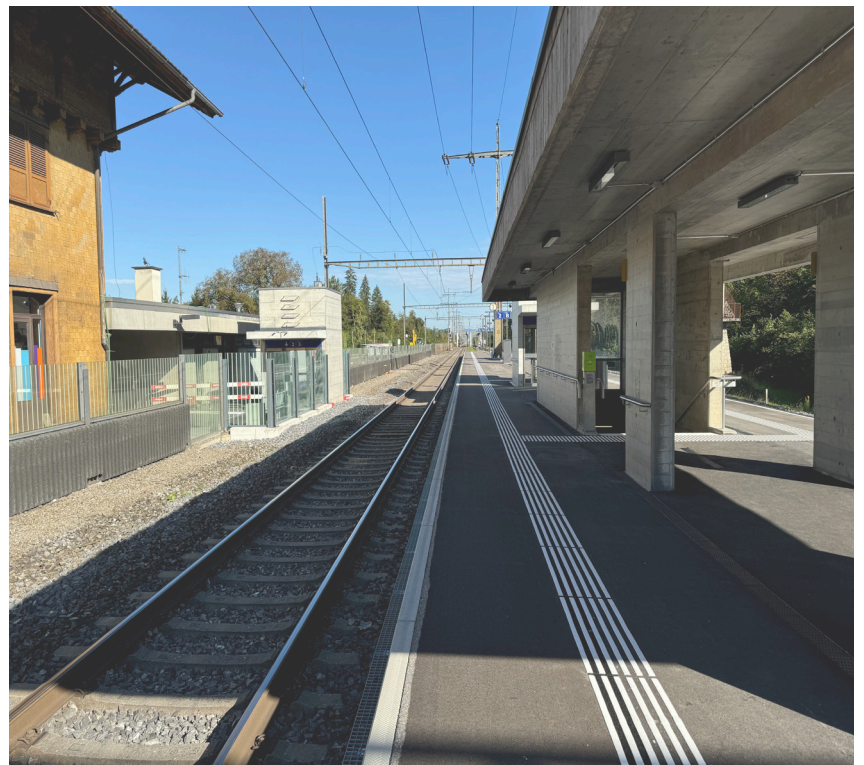
Perrondach SBB Bahnhof Uttigen
