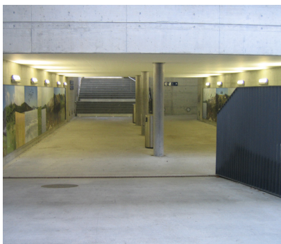
Neue zentrale Personenunterführung Glasbausteine zur Belichtung
