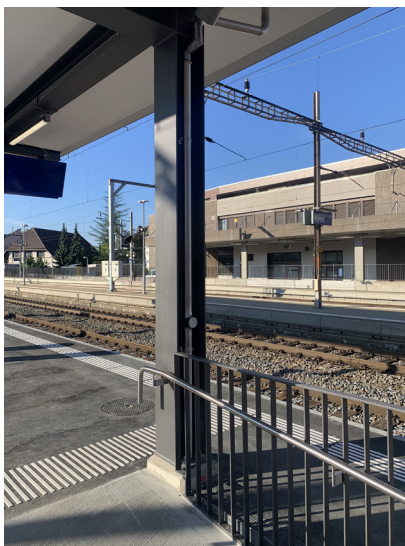
Staketengeländer mit Handlauf, Takt. Linien Massnahmen BZU23
