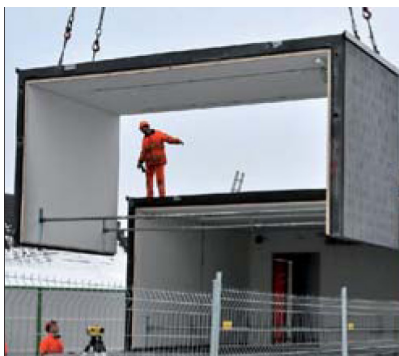
Neubau Fertigelementbau Betriebstechnikgebäude Brücke Scheibenstrasse
