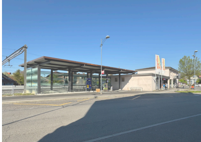
Unterführung SBB Bahnhof Brugg
