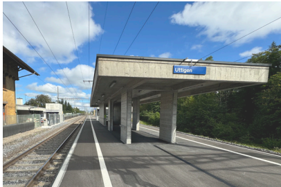
Perrondach SBB Bahnhof Uttigen
