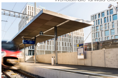
Bahnhof Wankdorf Neues Hausperron mit Überdachung
