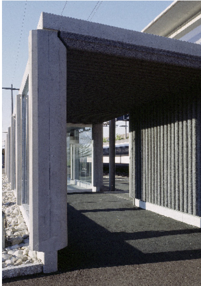
Lärmschutzwand mit Eingang auf Aussenperron SBB
