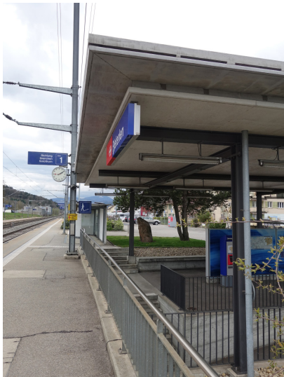
SBB Bahnhof Pieterlen Ansicht Perron
