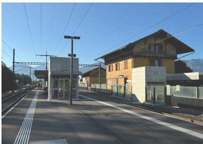
Lift SBB Bahnhof Uttigen
