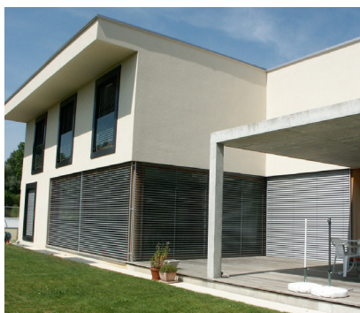
Einfamilienhaus Vorackerrain Gümligen Gartenansicht mit Gartenpavillon
