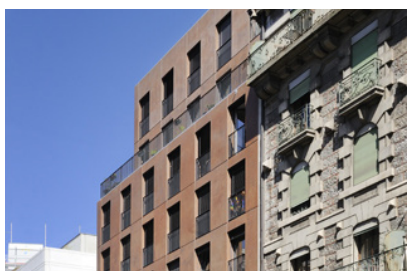
Projektierung & Realisierung Immeuble locatif Rue Du-Bois-Melly Genève
