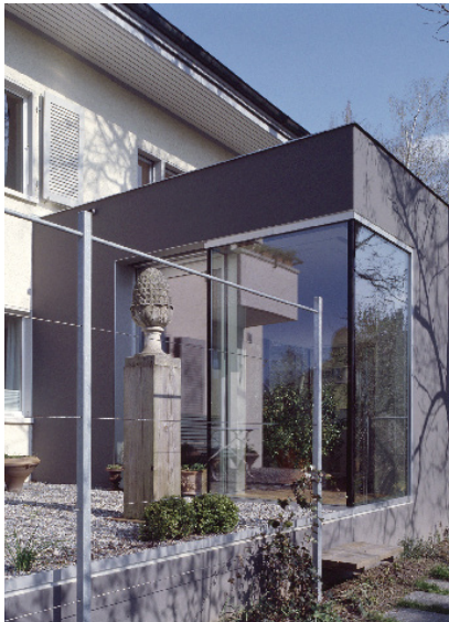
Umbau/Anbau Villa Mettlenhölzliweg Muri
