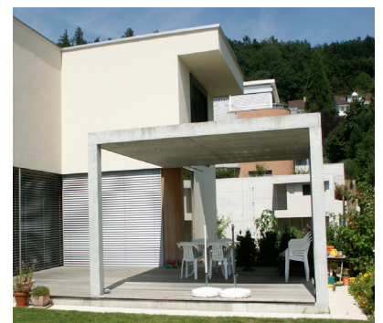
Einfamilienhaus Vorackerrain Gümligen Gartenansicht mit Gartenpavillon
