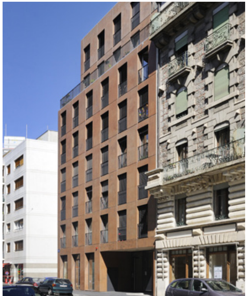
Façade Rue Du-Bois-Melly
