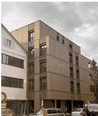
Erweiterung Güterstrasse 22 Bern Alt- und Neubau
