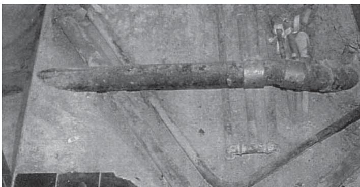
Einbetonierte Wasserversorgungs- und Abwasser-Leitungen verletzen das Prinzip der Trennung von Anlageteilen mit unterschiedlicher Lebensdauer.
