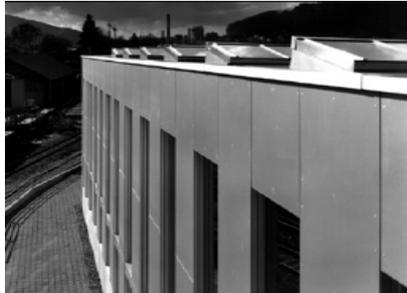
Fassade mit grossformatigen Eternitplatten und Oblichtern
